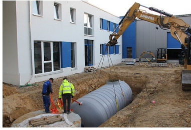
Bâtiment de l'entreprise INTEWA à Aix-la-Chapelle / Allemagne / 2019
