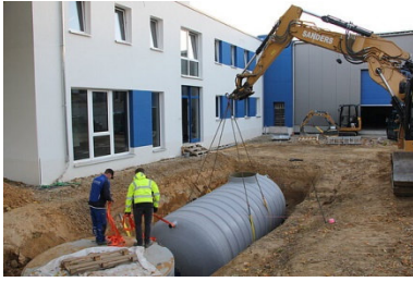
Bâtiment de l'entreprise INTEWA à Aix-la-Chapelle / Allemagne / 2019
